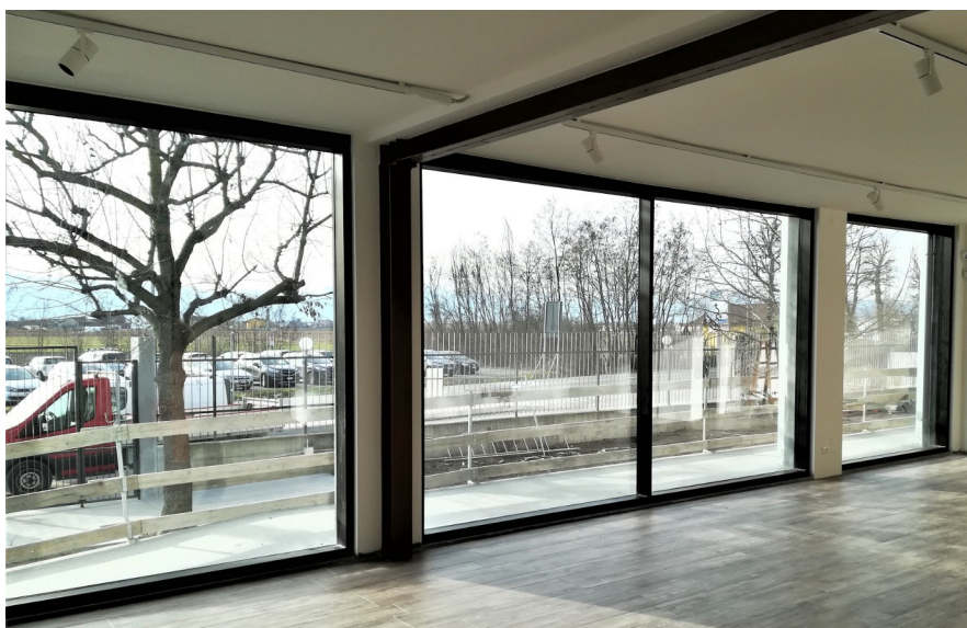
Profili da facciata su locale commerciale
